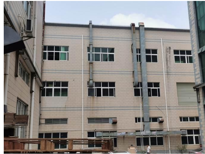
项目北侧厂房
