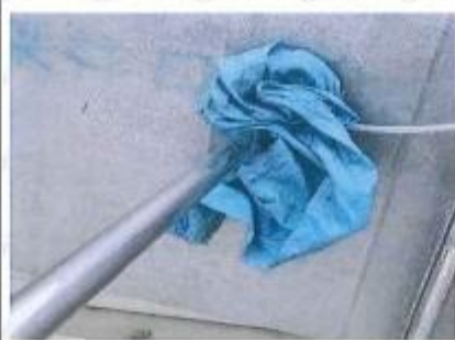
C 栋 DA001 废气处理前 1#检测口
