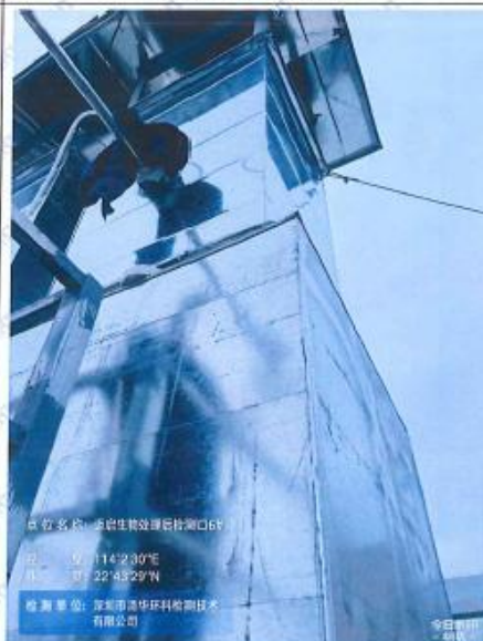
6#废气处理后检测口
