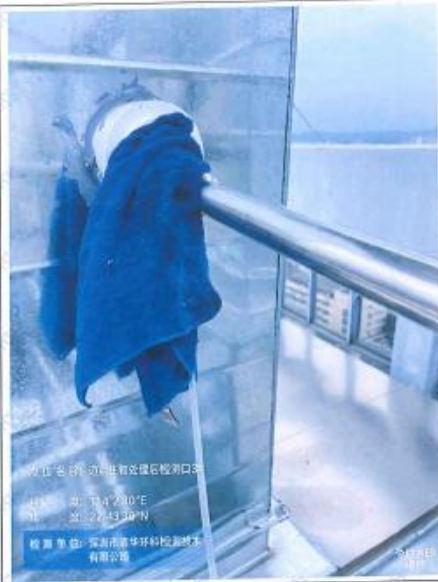
3#废气处理后检测口
